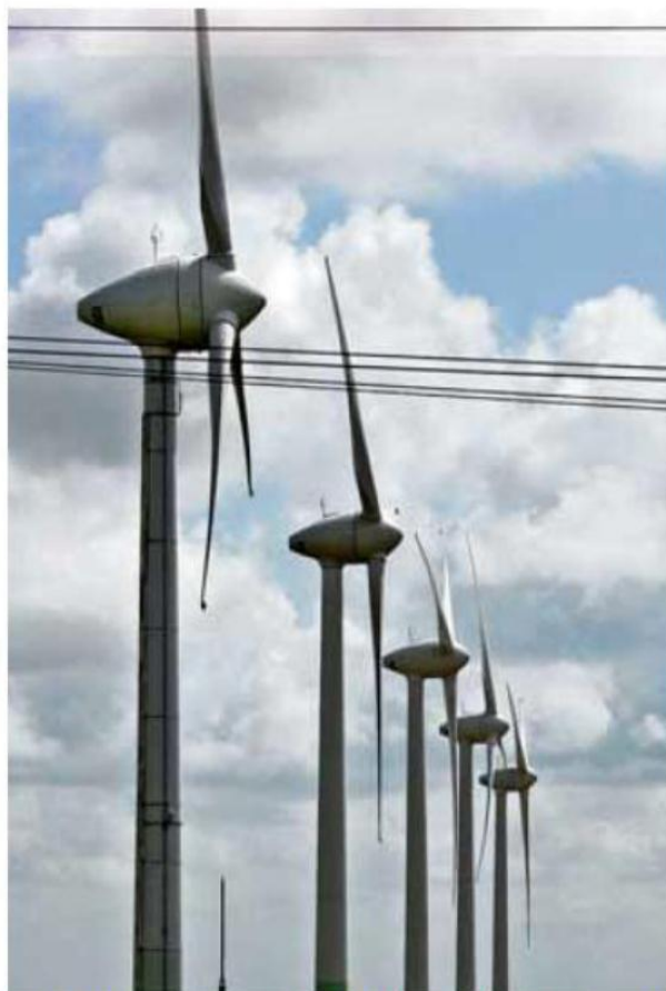
Der Wind bläst nicht auf Knopfdruck. Viele Unternehmen benötigen jedoch den Anschluss an die Leitungen eines unterbrechungsfreien Stromnetzes. Foto: Ulrich Weigel
