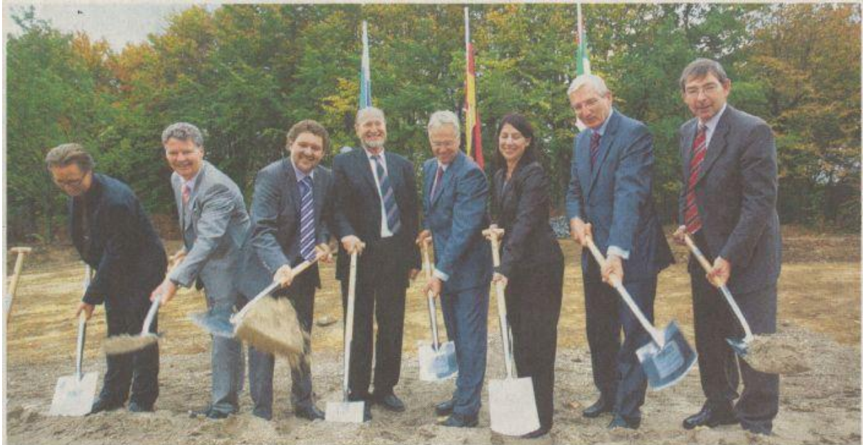
Spatenstich für den nächsten Neubau an der Uni: Gerd Merkle, Klaus Turowski, Axel Tuma, Hans Ulrich Buhl, Paul Waning, Katja Hessel, Alfred Gossner und Christian Ruck (von links) Foto: Alexander Kaya
